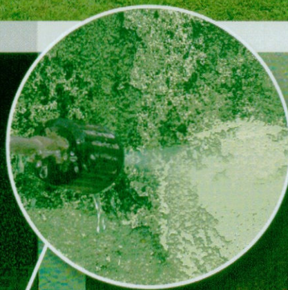
Powierzchnię czyszcimy za pomocą myki wysokociśnieniowej
