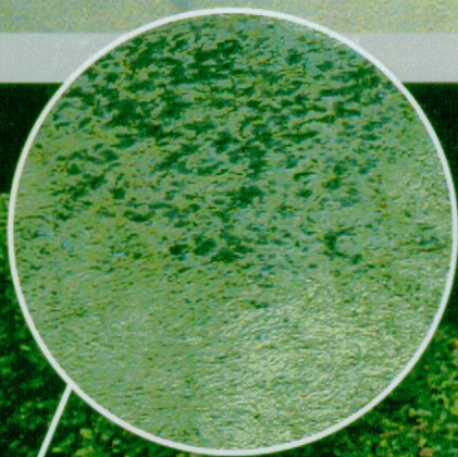
Powierzchnia zaatakowana przez grzyby i glony
